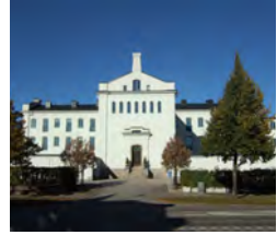
2001 Fängelset ombyggnad White Arkitekter Malmö AB Borätt
